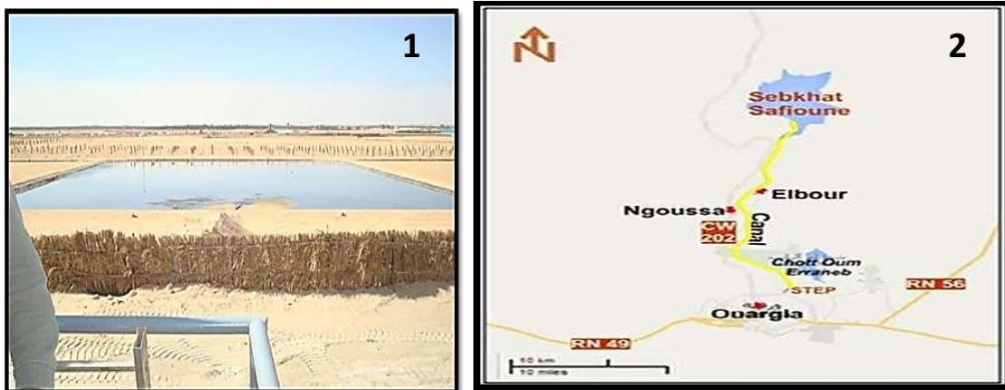
Figure 18 : Lits de séchages des boues récupérées de bassins (1) et Itinéraire d'acheminement des eaux épurées par canal de transfert (2) (STEP, 2020)
