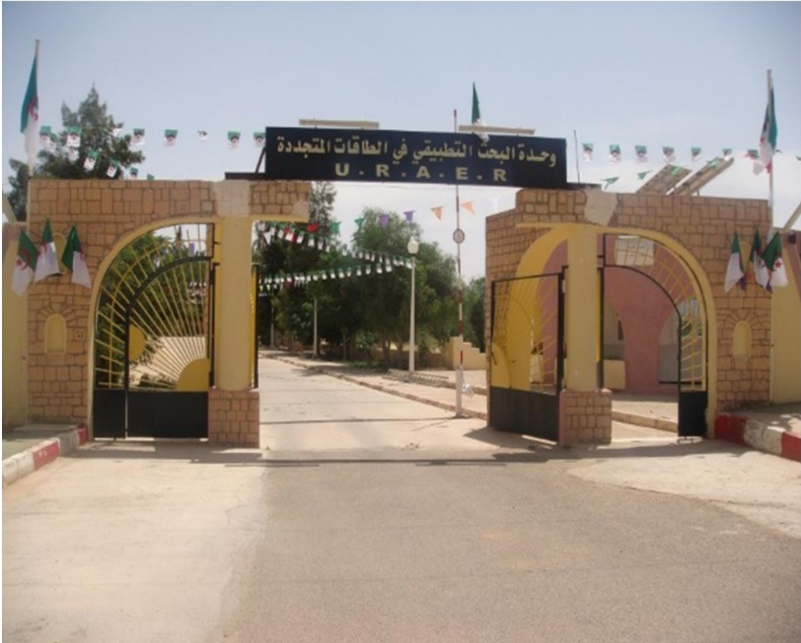
Figure (3- 3) : Unité de recherche appliquée en énergies renouvelables (URAER) Ghardaïa
