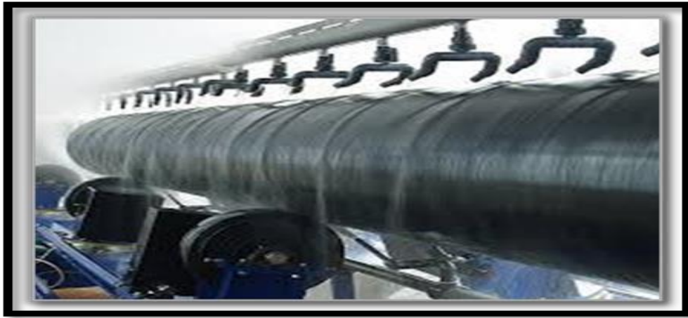
Figure I-24 Tunnel de refroidissement des tubes revêtus.
