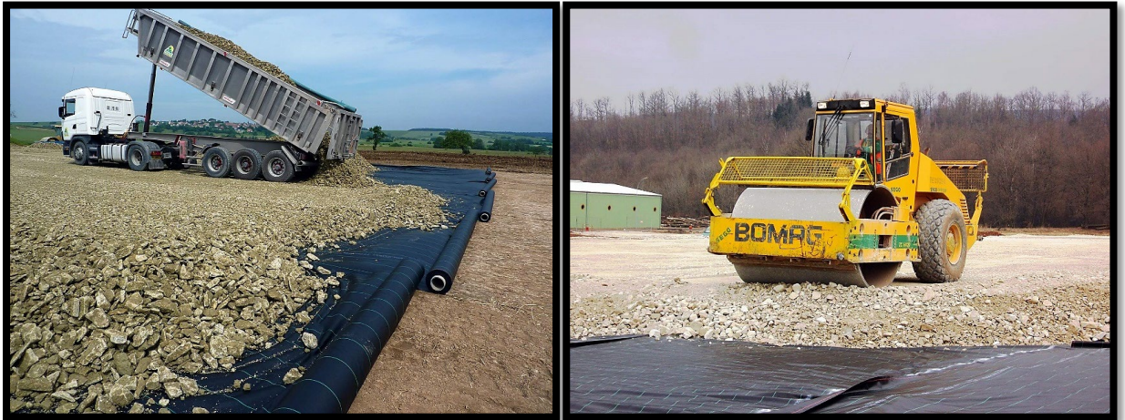
Figure II.11 Au moment de décharger le camion Figure II.12 Passage d'un compacteur lisse [39].
