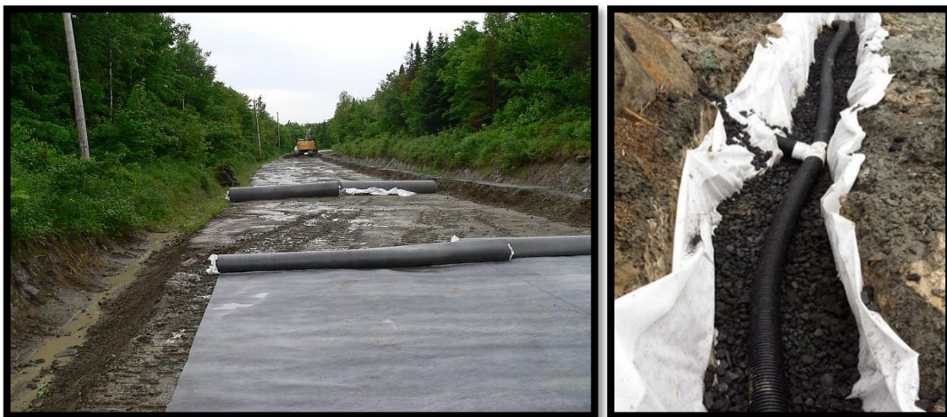
Figure II.2 : Réalisation d'opérations de couverture géotextile [39].
