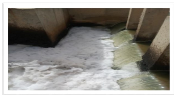
Figure 1: Dégrilleur et dessableur (STEP, Février.2022).
