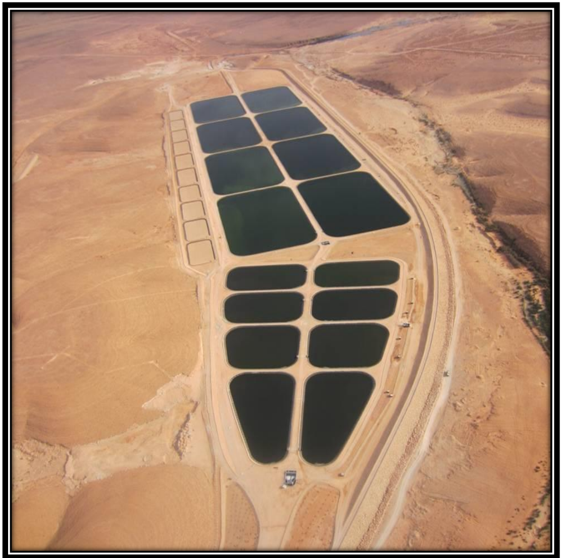
Figure II.8 : Vue aérienne de la STEP d'EL-ATTEUF [8]
