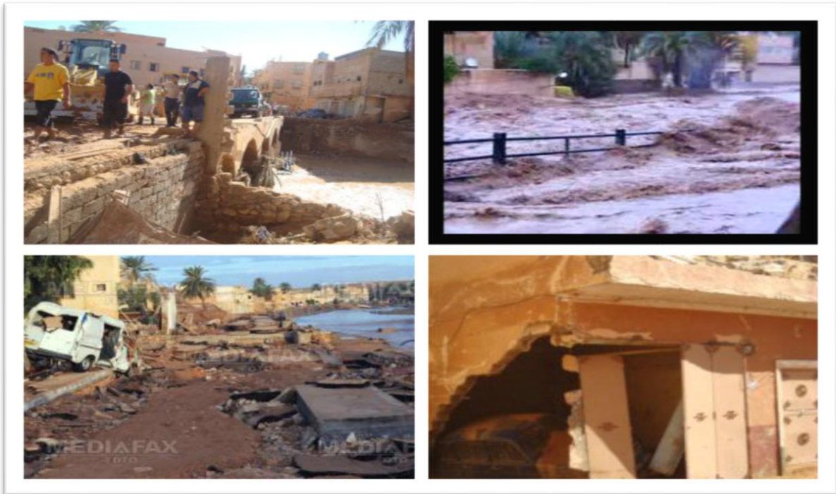
Photo N° 1 Quelques dégâts matériels –zone d'Addaoued -Ghardaïa
