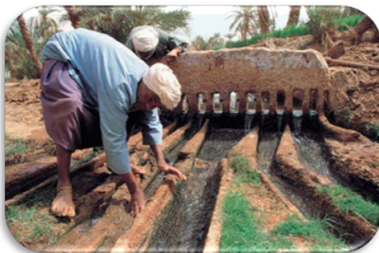
Figure 1.13 Système de transport et distribution d'eau [Foggara, dans la vallée de M'Zab] [4]
