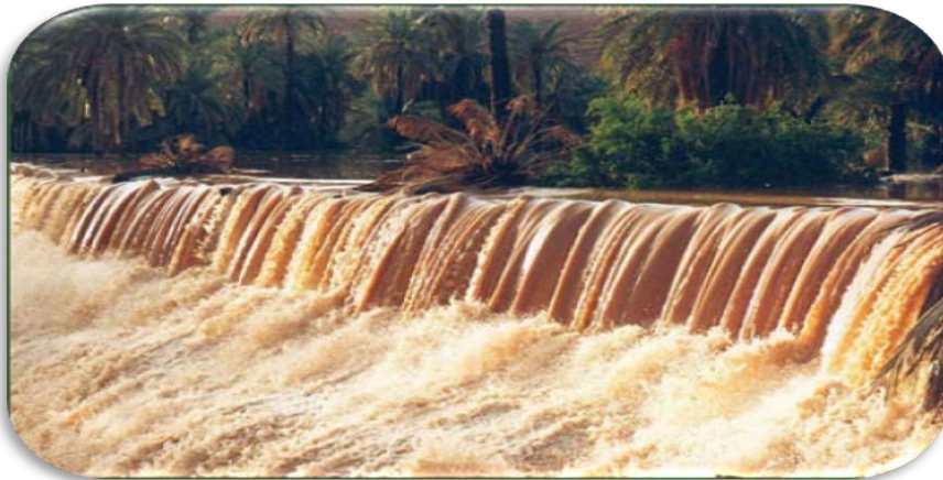
Figure 1.10. Inondation de la vallée de M'Zab [Oued Intissa le 1er octobre 2008] [4]
