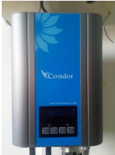
Figure 3.8 Convertisseur DC/AC.
