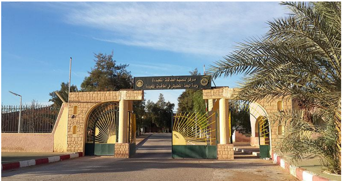
Figure 4.2 Unité de Recherche Appliquée en Energies Renouvelables Ghardaïa.
