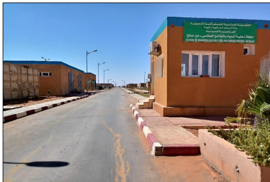
Annexe.17. La station de déminéralisation
