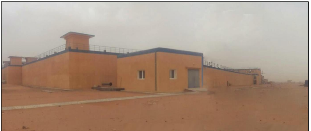
Photo IV.2: Réservoir de tête.
