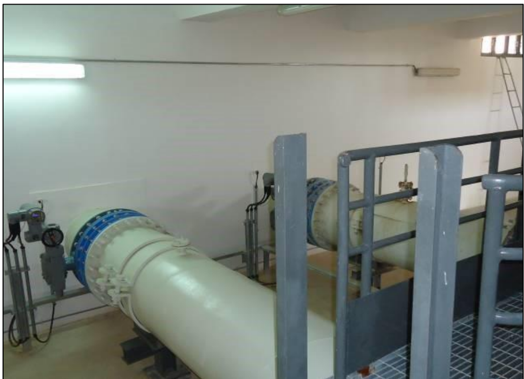
Photo IV.6 : Chambre de comptage
