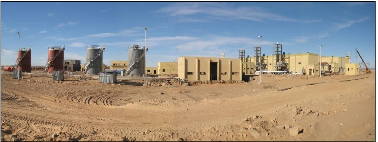
Annexe.16. Station de pompage SP2 – Vue générale
