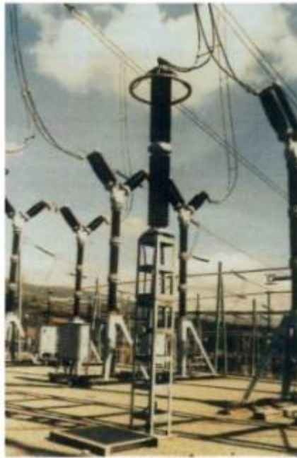
Figure III.3: exemple d'un parafoudre à oxyde de zinc (Z n O).
