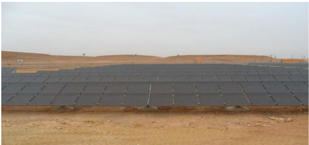
Figure IV.5 : Sous champs(4) : Technologie couche mince Amorphe a-Si sur structure fixe.[53]
