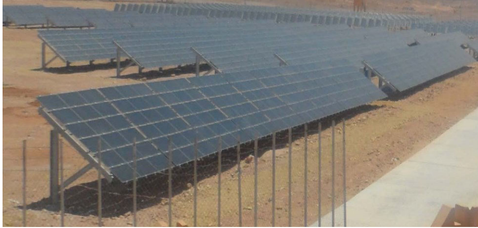
Figure IV.4 : Sous champs (3) : Technologie Couche mince CdTe sur structure fixe.[53]
