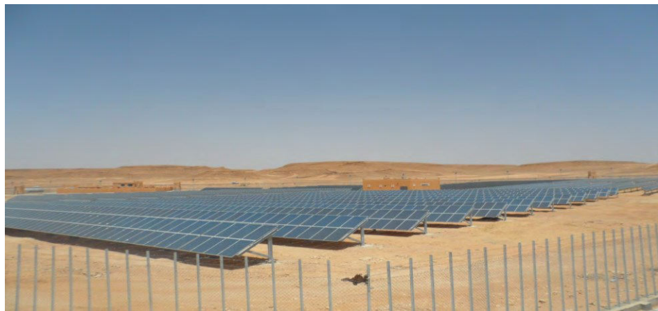
Figure IV.9 : Sous champs (8) : Technologie Polycristallin sur structure fixe.[53]
