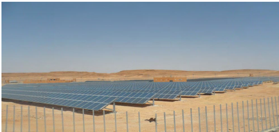
Figure IV.7 : Sous champs (6) : Technologie Polycristallin sur structure fixe.[53]
