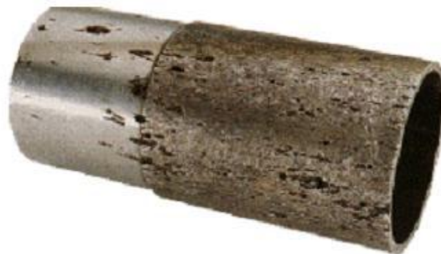
Figure I.5. Corrosion par piqûres d'un acier inoxydable [11]
