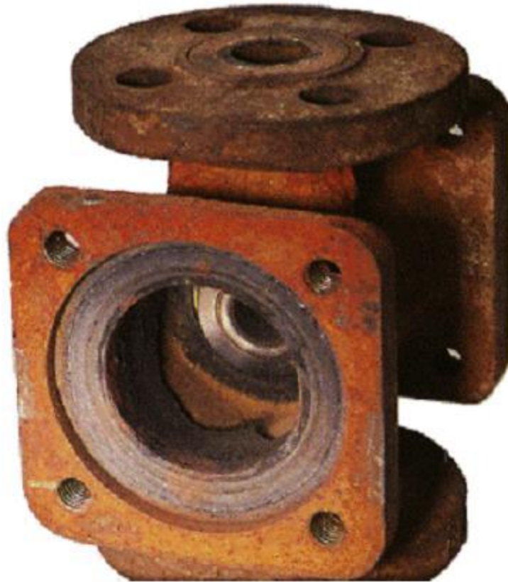
Figure I.2. Corrosion générale (rouille) d'une pièce en acier [11]
