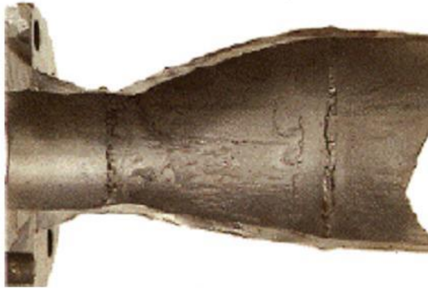
Figure I.8. Corrosion-érosion dans une zone turbulente [11]
