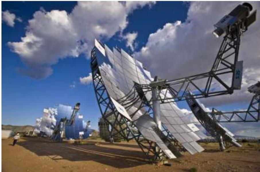
Figure III.10 : Capteur parabolique "Dish-stirling" à Phoenix, Arizona
