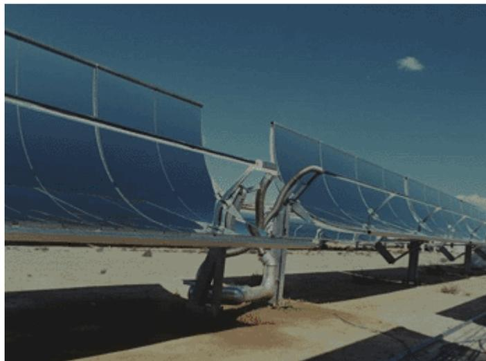
Figure III.9 : Le collecteur cylindro-parabolique
