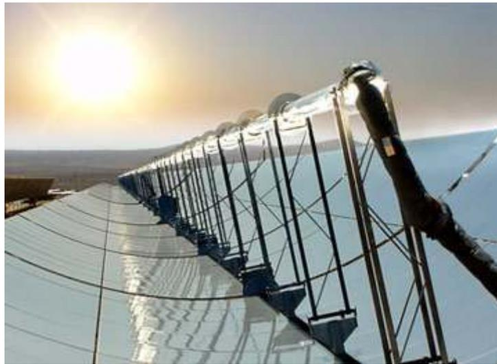
**Figure III.3 : Concentrateur cylindro-parabolique de la centrale de Nevada Solar One**
