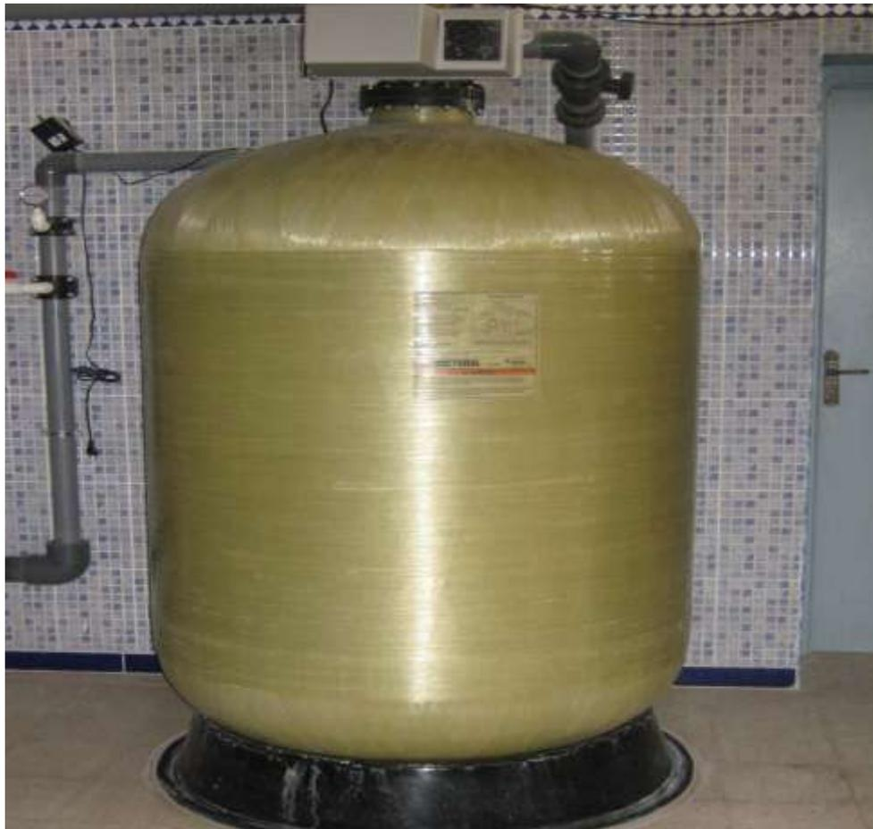
**Figure N°21 - Filtre à sédiment**
