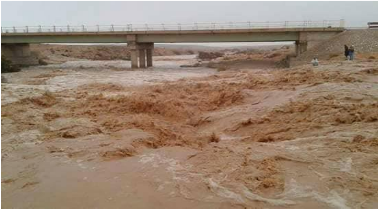
- le pont de oued Zegrir dans un cas de crue
