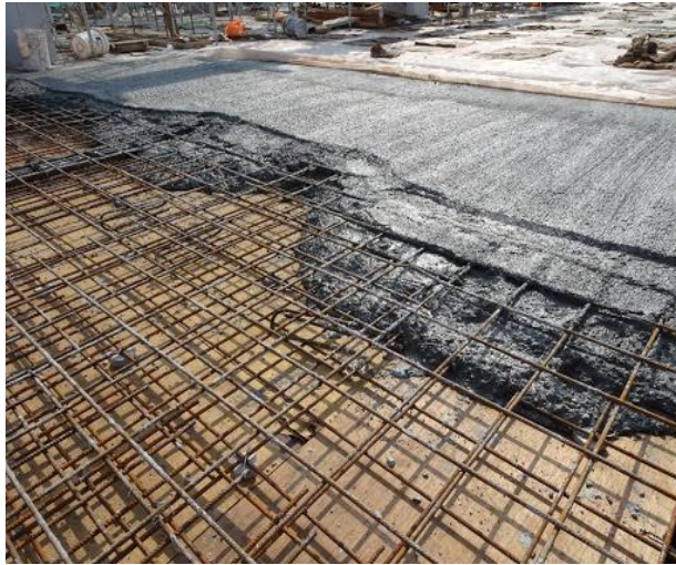
Photo N° 1-03 : Coulage fondation radie (guide béton)
