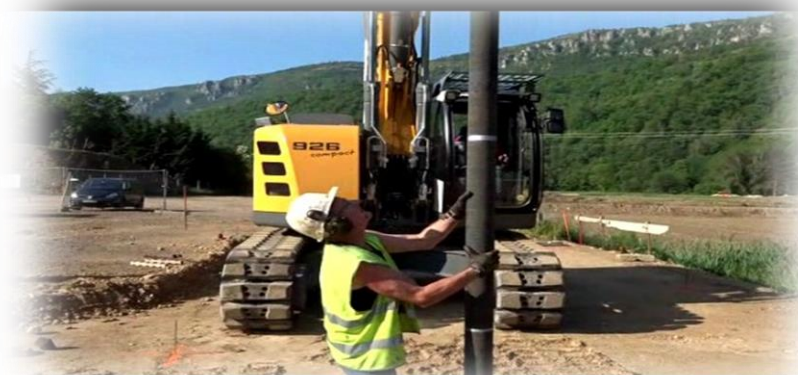
Photo N° 1-06 : la pose d'un pieu battu (CAZES fondation spéciales)
