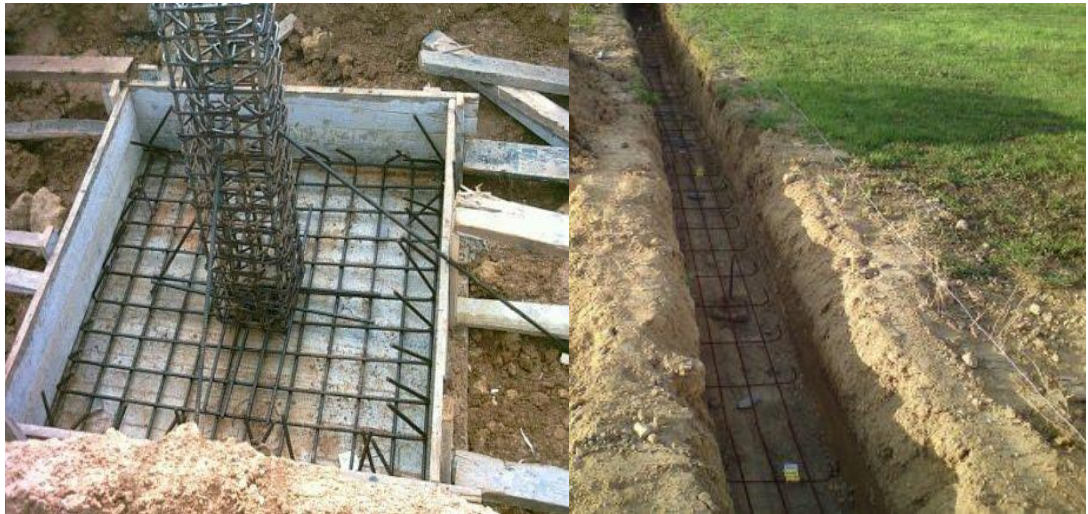
Photos N° 1-01 et 1-02: armature semelle isolée (METRE ferrailage / semelle isolée).
