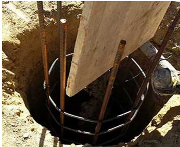
Photo N°1-04 : coulage pieu foré (LGA engineering)
