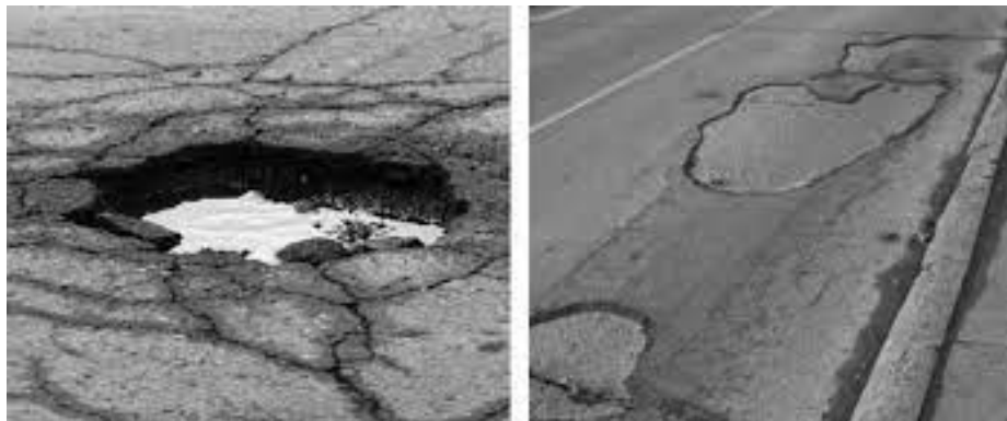
Photo II.1. Quelques cases de l'influence de l'eau sur la chaussée.
