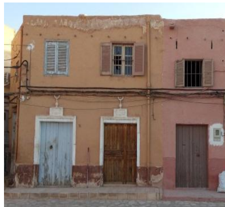
Figure 63: infiltration des eaux pluviales et eaux usées. Pris par les étudiants
