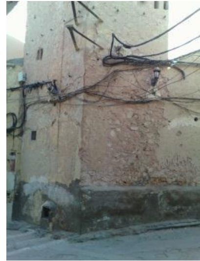
Figure 67: Fils d'électricité apparent qui défigure le façades. Pris par les étudiants
