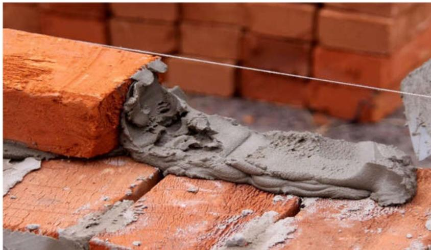
Figure I.7. Pose de mortier de hourdage.
