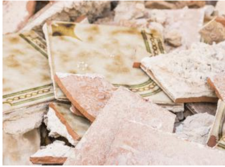
شكل رقم (8.II) يوضح بقايا البلاط أرضي
