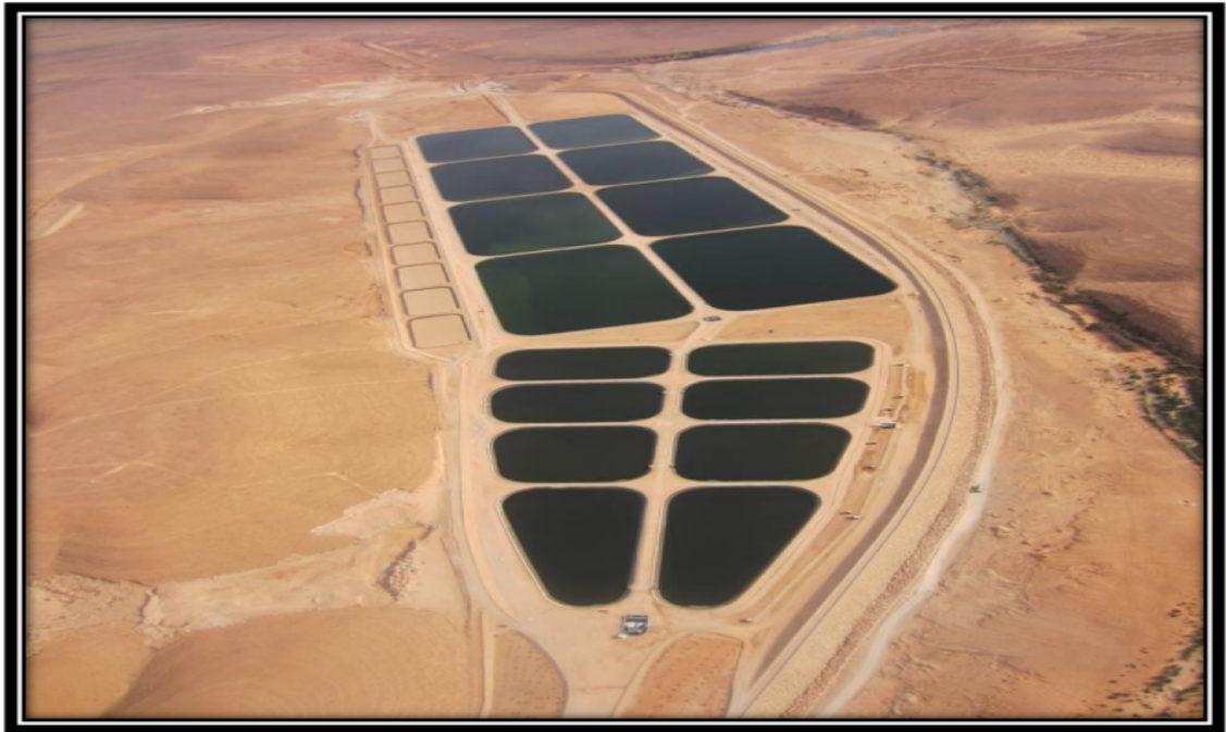
FIGURE 2.3 – Vue aérienne de la STEP d'EL-ATTEUF (Google earth, 2022)
