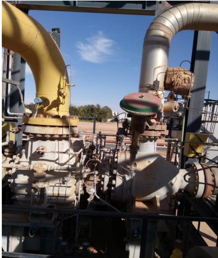
Figure III.11: Le turbo-expander au niveau de module IV.
