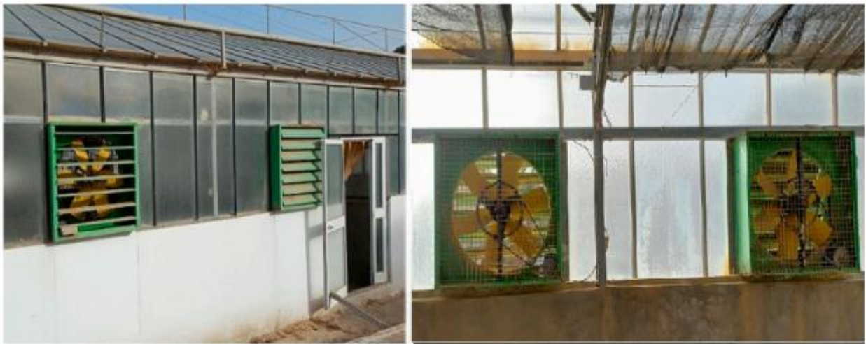
Fig.II. 4 : Une serre équipée de dispositifs de ventilation forcée à l'Institut des Régions Arides.
