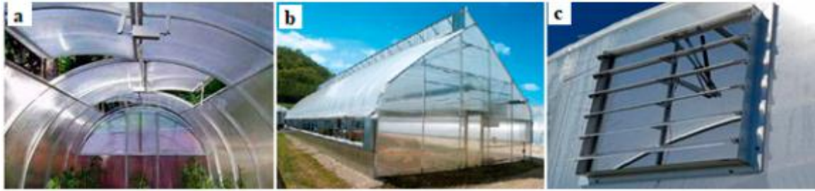
Fig. II. 3 :Différents types d'ouvertures de serre : (a) événements de toit ; (b) événements de façade ; (c) événements latéraux.
