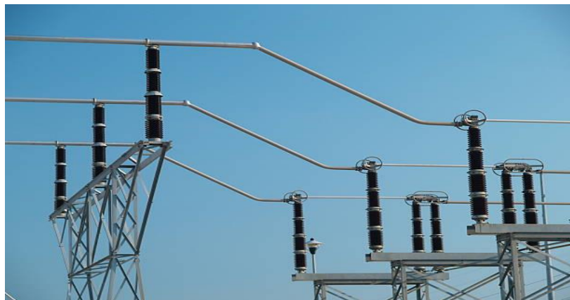
Figure II.3 : Jeux de barres
