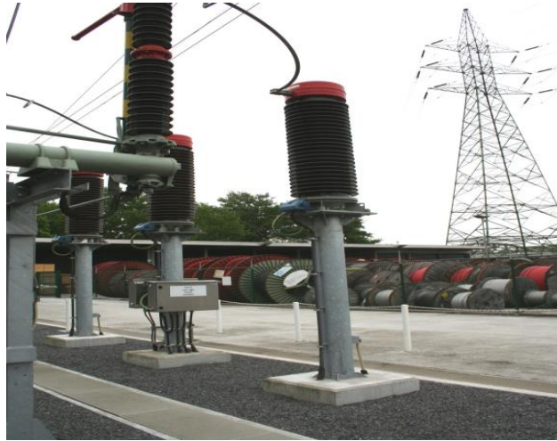
Figure II.9 : Transformateur de tension
