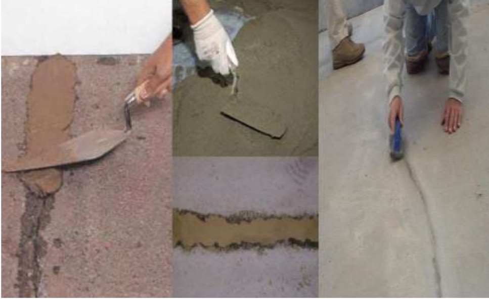
صورة (5.4): حقن الشروخ بمواد إيبيوكسية ومسحها بمونة إسمنتية. مصدر: أسامة طارق، ترميم وتدعيم المنشآت الخرسانية ، مرجع سبق ذكره، ص 32.
