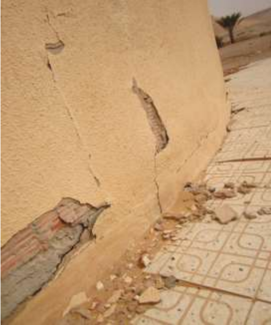
صورة (14.5): شقوق أفقية أسفل العمود. صورة (15.5): تفتت الغطاء الخرساني بسبب الضغط.
