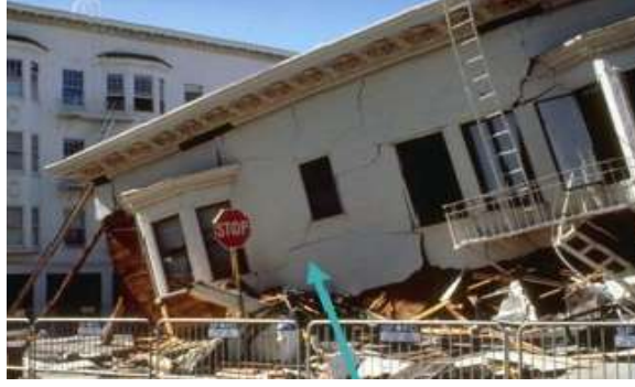
الصورة (3.2): هبوط غير متساوي (ميل) للمبنى مع شروخ في اتجاه الميل. المصدر: سيف الدين أحمد (2017/03/28)، مرجع سبق ذكره.
