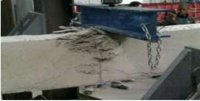
صورة (12.2): شروخ نتيجة أحمال زائدة (شروخ ضغط). مصدر: سيف الدين أحمد (2017/03/28)، مرجع سبق ذكره.
