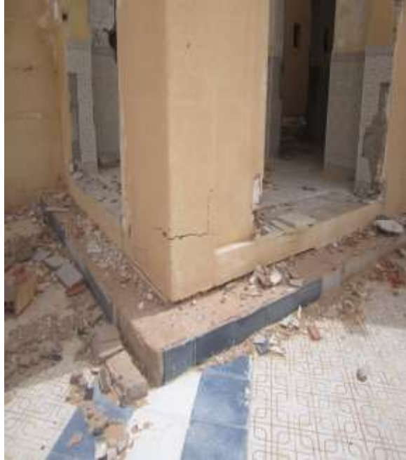
صورة (14.5): شقوق أفقية أسفل العمود. صورة (15.5): تفتت الغطاء الخرساني بسبب الضغط.
