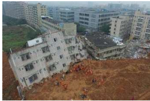
الصورة (4.2): انزلاق لمبنى. المصدر: سيف الدين أحمد (2017/03/28)، مرجع سبق ذكره.
