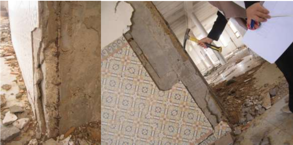
صورة (28.5): الكشف عن حديد التسليح عن طريق تحطيم الخرسانة.
