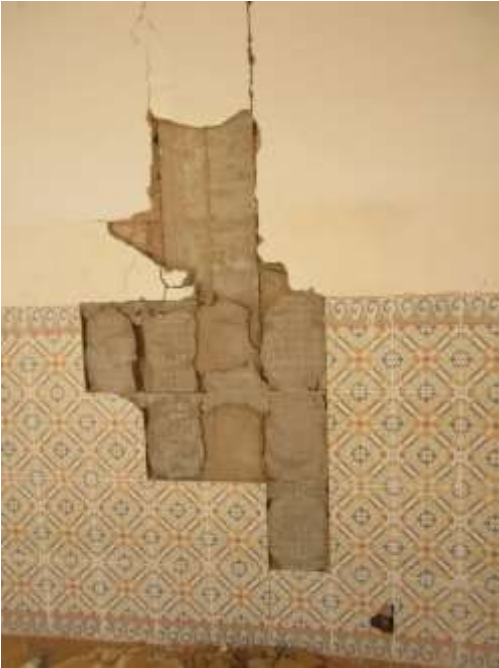
صورة (22.5): سقوط رخام الجدار قرب العمود.
