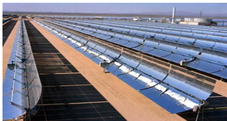
Figure 1.4 : Les capteurs d'une centrale solaire thermodynamique [7]
