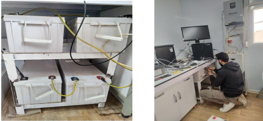
Figure 3.9 : Assemblage des batteries et leur raccordement avec l'onduleur.
