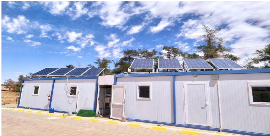
Figure 3.6 : Installation des modules PV sur le site expérimental.
