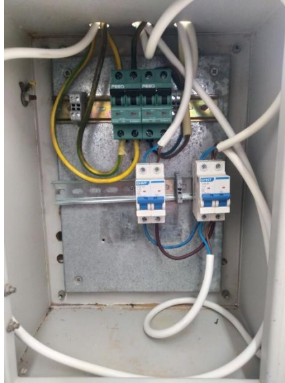
Figure 3.7 : Armoire de raccordement du système photovoltaïque.
