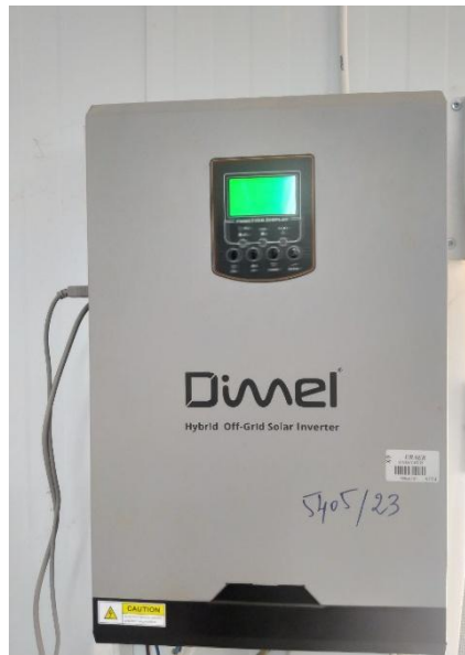
Figure 3.8 : Onduleur hybride Axpert VM II (3 kW) utilisé dans le système expérimental.
