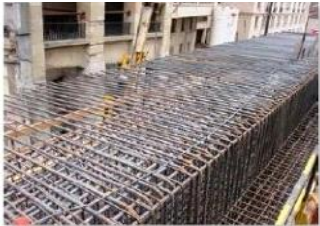
Figure (I.3) : Un BAP constitue la solution idéale pour des éléments de structure fortement armés [17].
