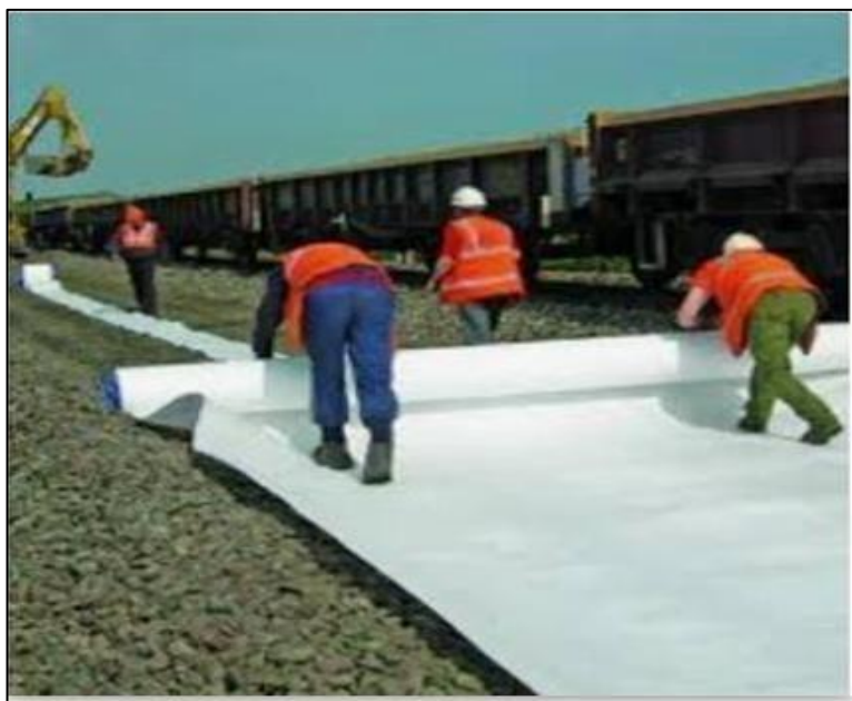
Figure IV.5 : Le techniques de la stabilisation par géotextiles [48] .
