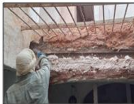
Figure IV.24 : détérioration des poteaux due à des charges excessives [28]
