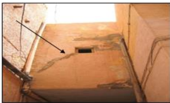
Figure IV.36 : Traitement d'une fissure au ciment [28]
