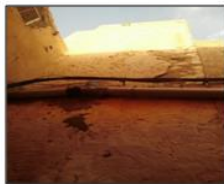
Figure IV.14 : pathologies liées aux réseaux d'électricité [28] source : auteur
