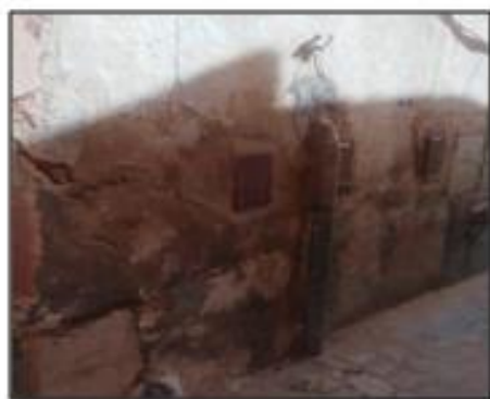
Figure IV.13 : la remontée capillaire d'eau (l'humidité) [28] source : auteur
