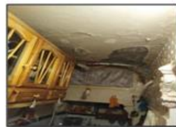
Figure IV.12 : problèmes de l'étanchéité [28]
