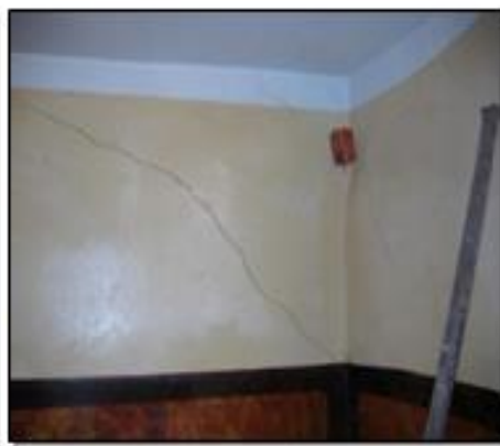
Figure IV.5 : Fissures au niveau du mur et plancher [28]
