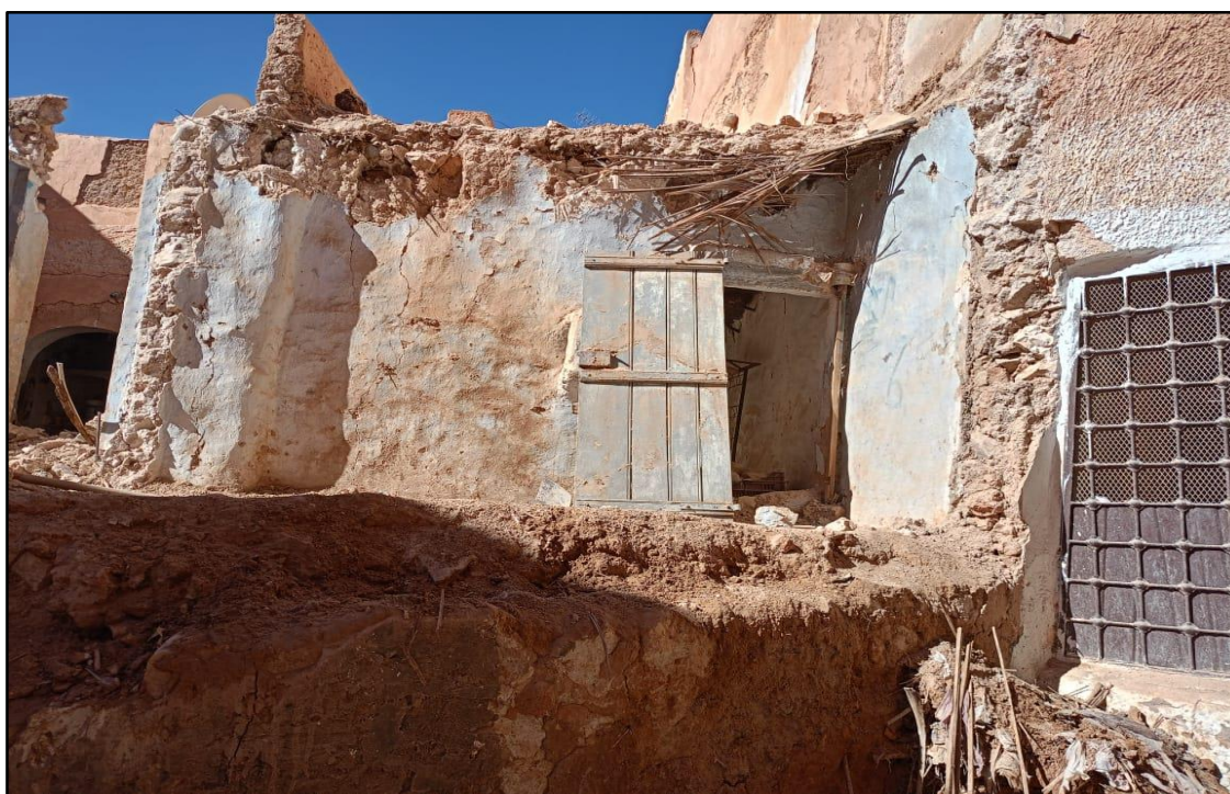
Figure IV.1 : détérioration et d'effondrement dans une habitation dans le ksar de Mlika [28]
