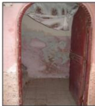
Figure IV.7 : Remontée Capillaire D'eau (L'humidité) dans le mur [28]
