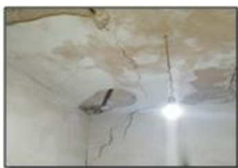
Figure IV.10 : fissures au niveau du plancher [28]
