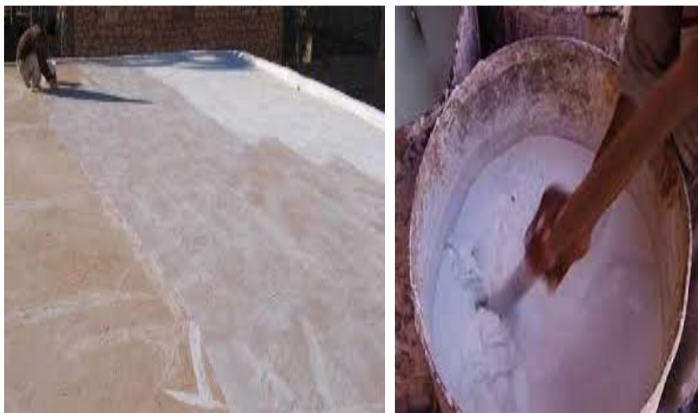
Figure I. :11 préparer la chaux pour la peinture [10]
