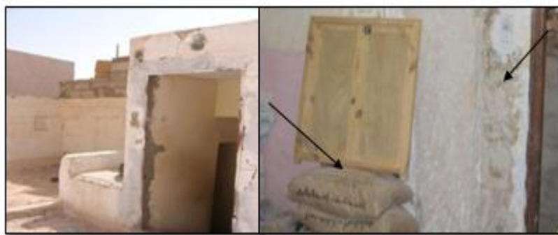
Figure IV.9 : Utilisation du ciment dans les travaux de restauration au Ksar de Mlika [28]
