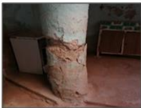
Figure IV.25 : injection de mortier à la chaux [28]
