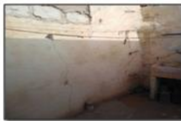
Figure IV.11 : Fissures préjudiciables au niveau de mur [28] source : auteur
