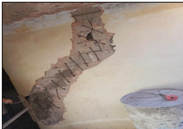
Figure I.13 : Renforcement des Murs [13]
