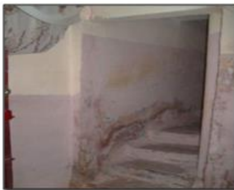
Figure IV.3 : humidité nuisible à la structure [28]
