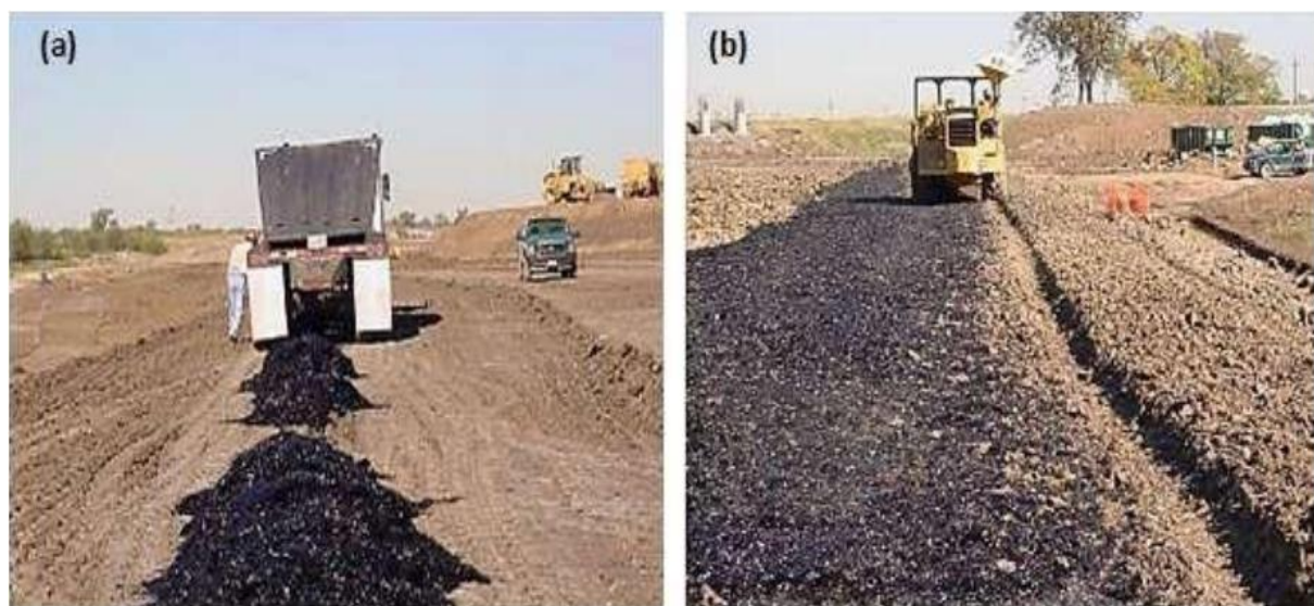
Figure 1:14 (a). Mise en place de fibres avec le sol, (b). Répartition et compactage des fibres sur le terrain Projet PGBT situé dans la région de Dallas, Texas (Gregory, 2006).
