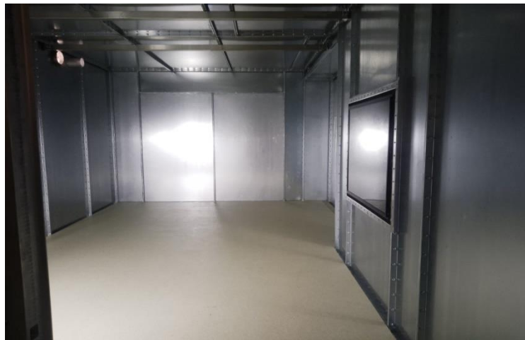
Figure3.8. Cage Faraday d'une Chambre d'examen
