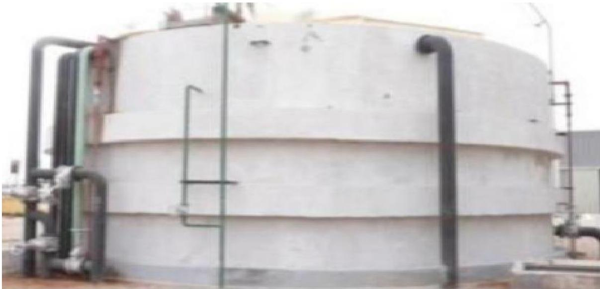
**Figure 9 Bac tampon le de pré -déshuilage S-101**
