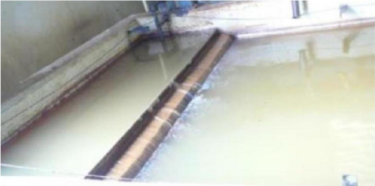
**Figure 11 Corrugated Plate Interceptor CPI « S-102 »(22/042019)**
