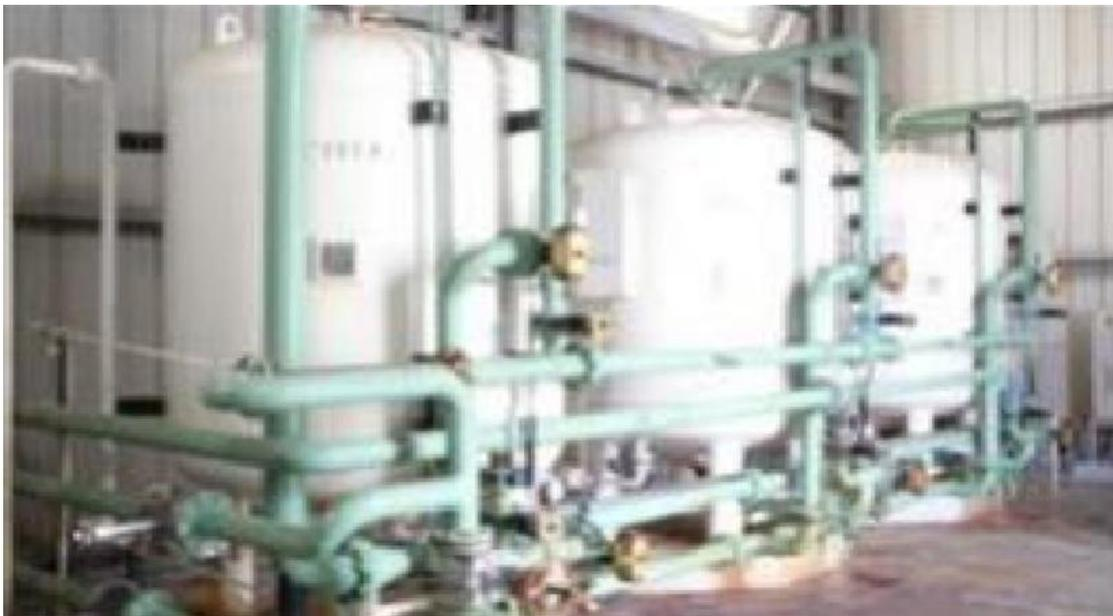
**Figure 15 les filtres à sable**
