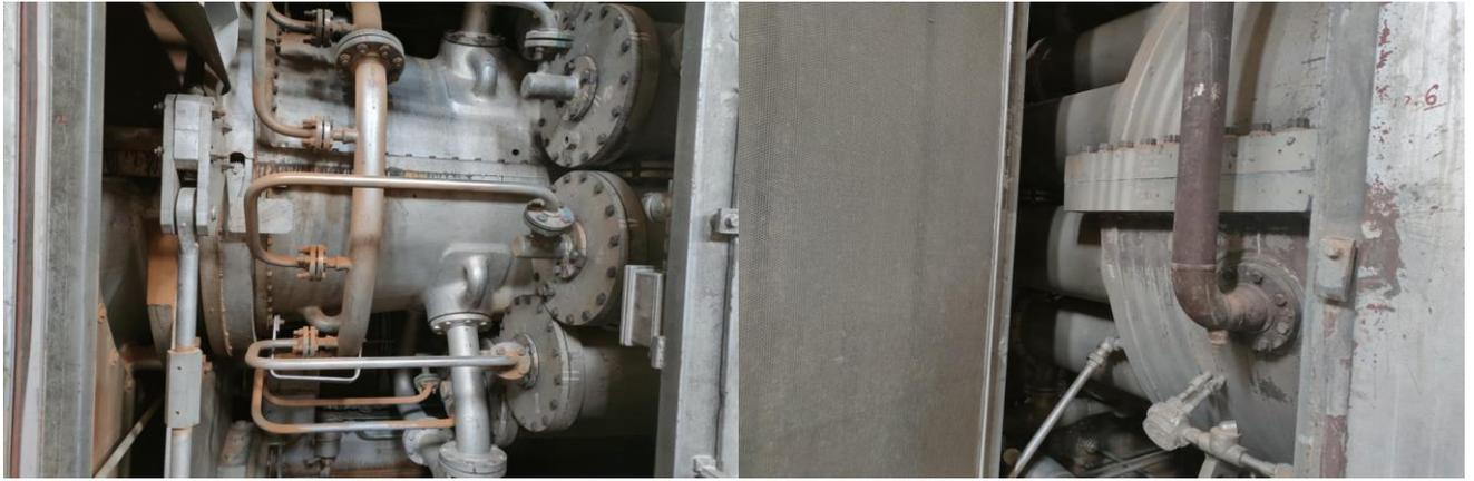
**Figure II.10 : Section de combustion vue externe**
