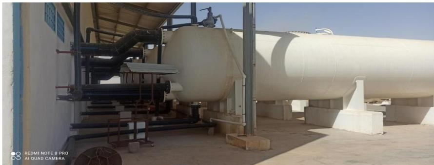
Figur III-12: filtres à sable
