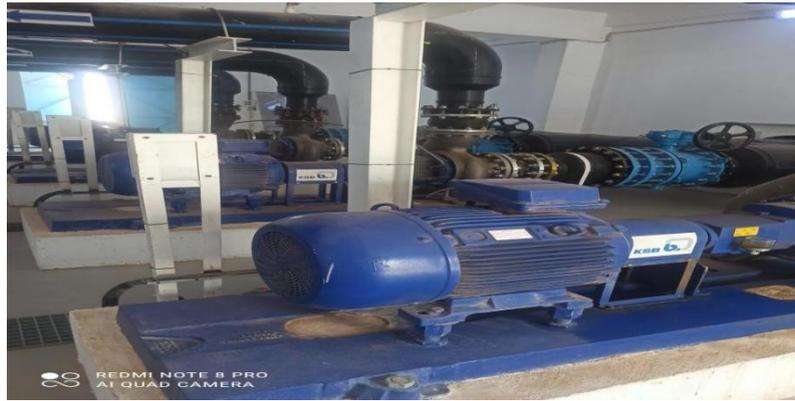
Figur III-11: Les pompes d'alimentation des filtres à sable sont illustrées
