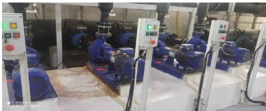
Figure III-13: Pompes d'alimentation de filtres à cartouche
