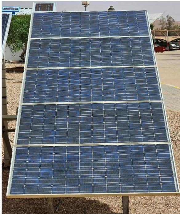
**Figure 2-5:** Un panneau photovoltaïque monocristallins
