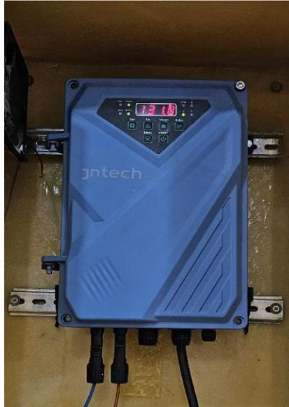
Figure 2-3: Photographie d'un onduleur
