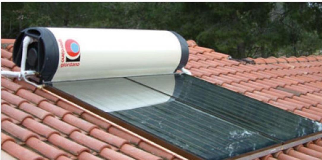
**Figure 2-6:** Représentation du système de chauffe-eau solaire[4]
