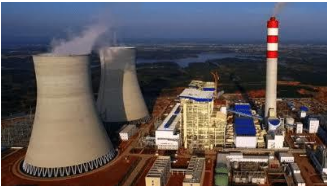
Figure1. 4 : Centrale thermique a vapeur
