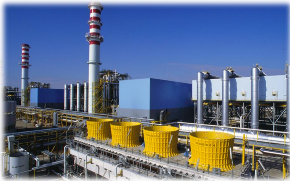
Figure1. 8 : centrale à gaz à cycle combine
