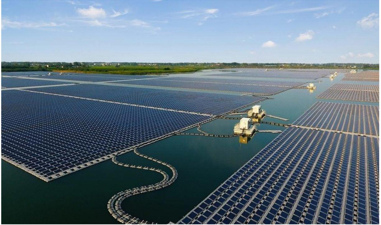
**Figure 5:** centrale solaire flottante de la société Sungrow construite sur un lac formé par une ancienne mine de charbon inondée à Huainan [10].
