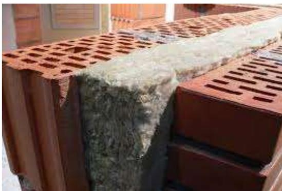
Figure 2.15 : Exemple sur l'isolation intégrée[6].
