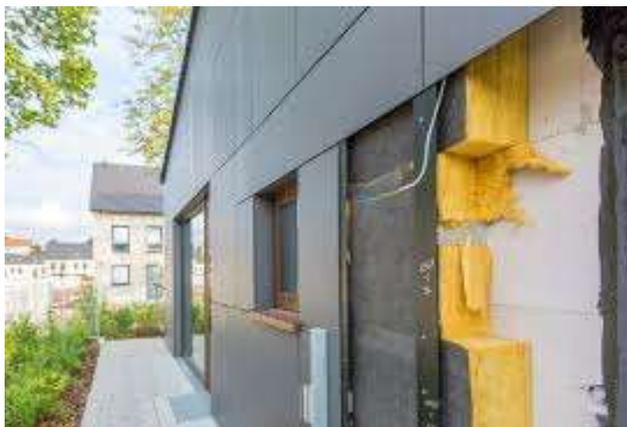
Figure 2.14: Exemple sur l'isolation par extérieur[6]
