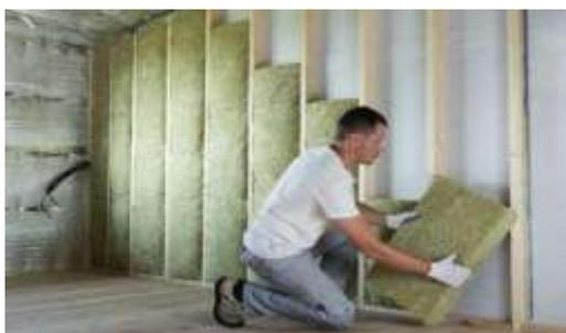
Figure 2.13: Exemple sur l’isolation par intérieur[6]
