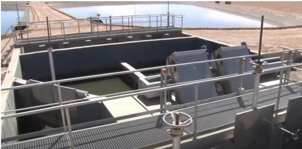
Figure 2: Dégrilleurs de station d'El-Ateuf de la ville de Ghardaïa
