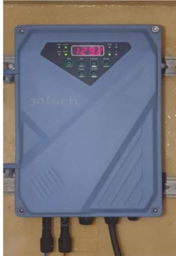
Figure 3-7: contrôleur équipé de la technologie MPPT
