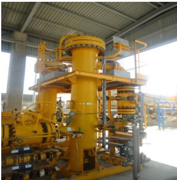
Figure 43 : Filtre vertical de type cartouches coalescentes
