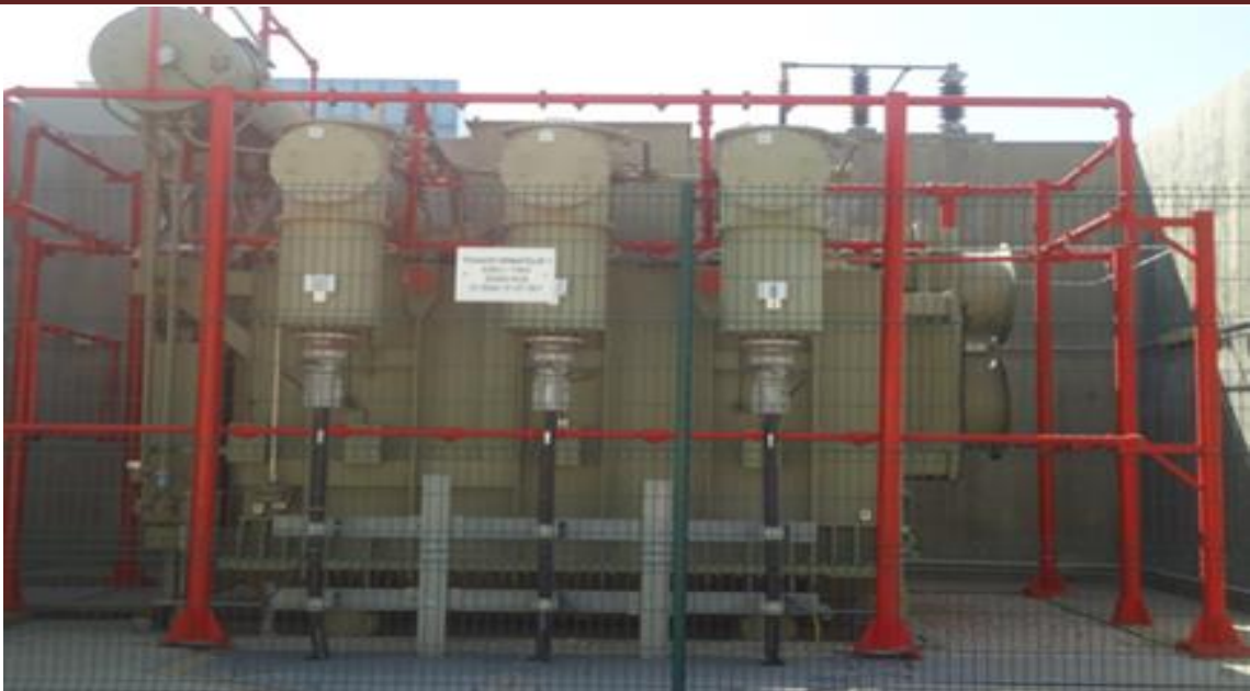
Figure 52 : Transformateur principale
