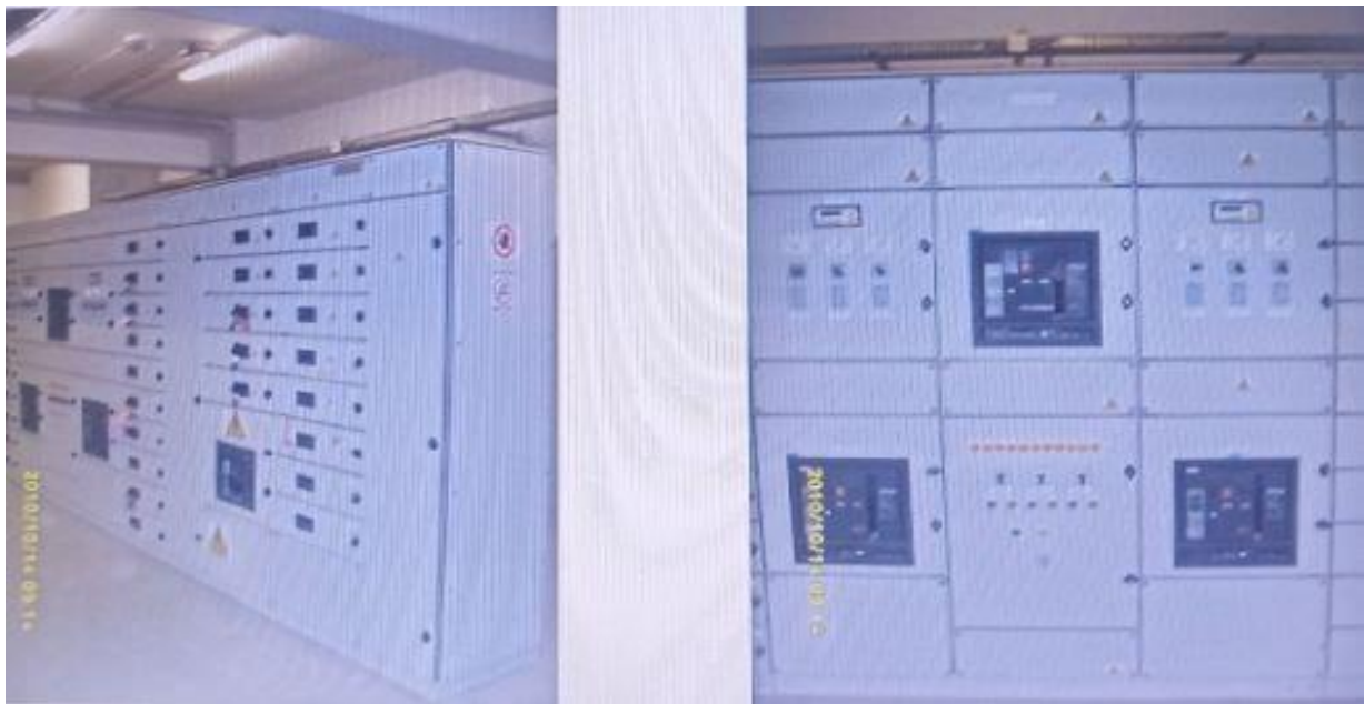
Figure56 : Tableau BT principal 400V 00BFA10 [15]
