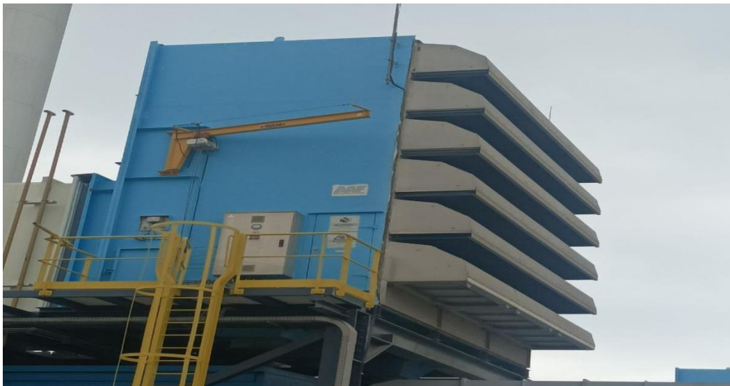
Figure 58 : Chambre d'admission d'air
