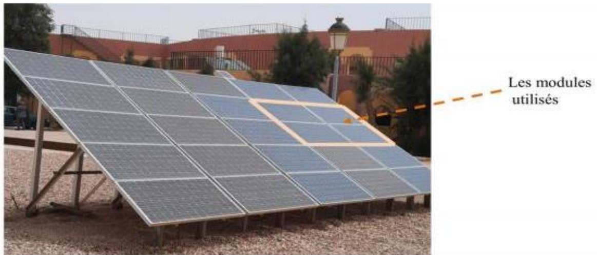
**Figure III.1 :** Générateur photovoltaïque utilisé.
