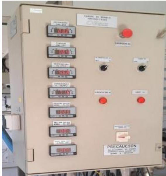
**Figure III.10:** Armoire d'affichage des mesures instantanées
