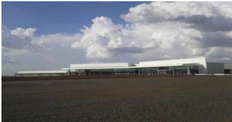
**Figure I.3. Le nouvel aéroport « Brisbane West Wellcamp » en Australie réalisé avec un béton géopolymère. [43]**
