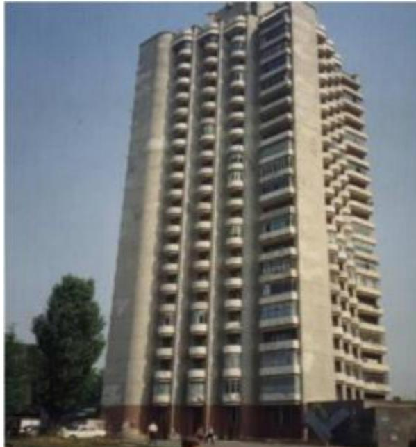
**Figure I.5. Première structure en béton géopolymère a été construite en 1994 à Lipetsk, en Russie, [84].**
