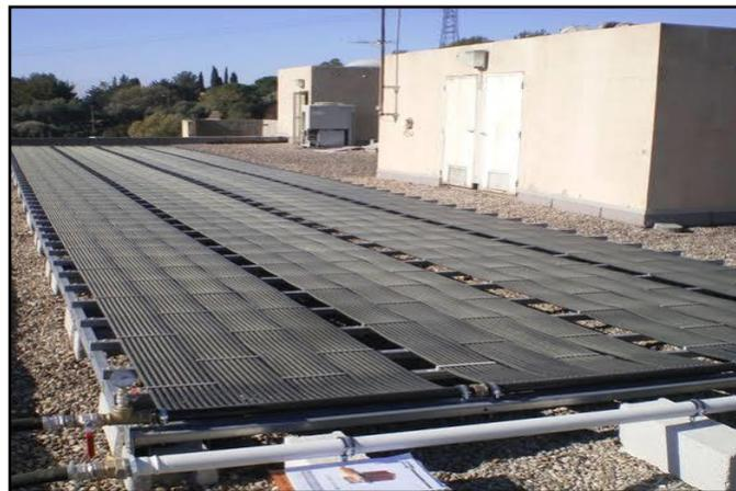
**Figure (I.9):** Capteurs plans sans vitrages.
