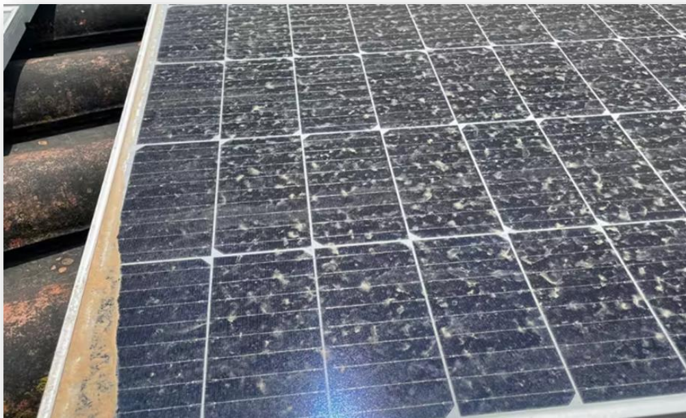
Figure I.1 : Panneau solaire recouvert de poussière et de saleté
