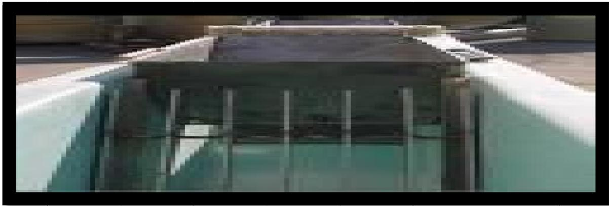
**Figure (3) Dégrilleur manuelle**
