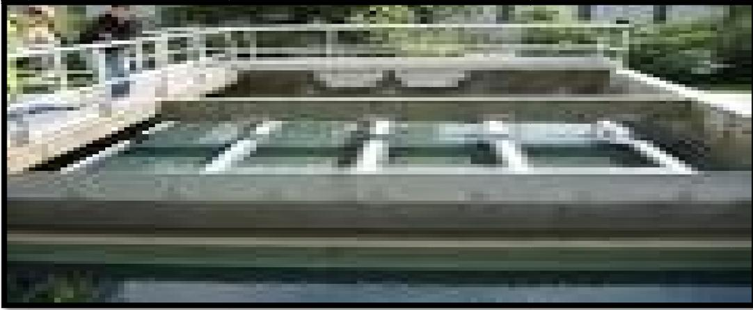
**Figure (8) : bassin de Coagulant, site électronique(4)**
