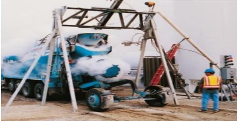
**Figure I.5.** Azote liquide ajouté au malaxeur pour abaisser la température du béton.
