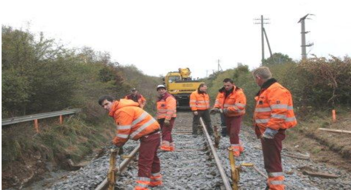
FIGURE 33 : EMBLACEMENT DES JALONS ET PIQUET
