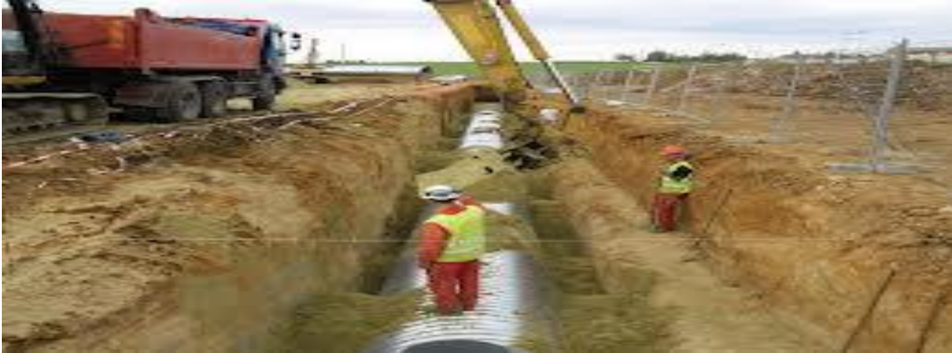
FIGURE35 : TRAVAUX DE REMBLAIEMENT
