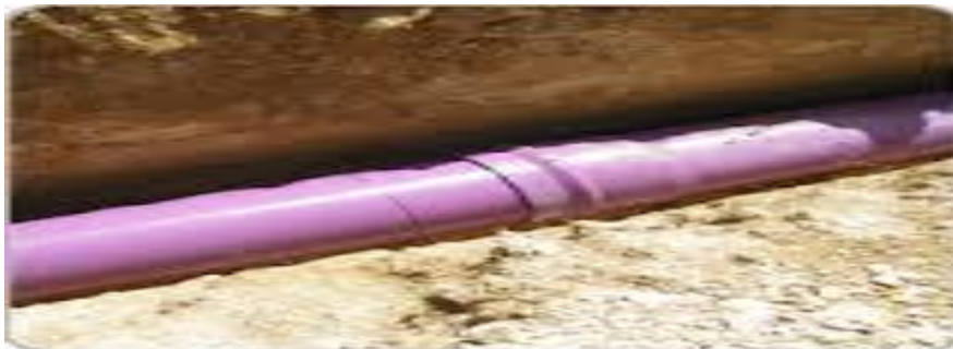
FIGURE 36 : ASSEMBLAGE DES CONDUITES PVC
